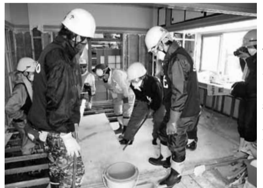
個人宅での復旧作業
